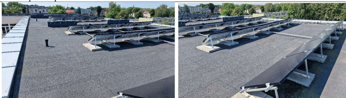
Stogo dalis virš remontuojamų patalpų.
